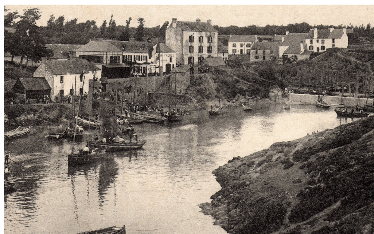
Usine Pellier, début 1900. Sur la droite nous apercevons le môle intérieur fraîchement construit et la maison Philippon au-dessus.
