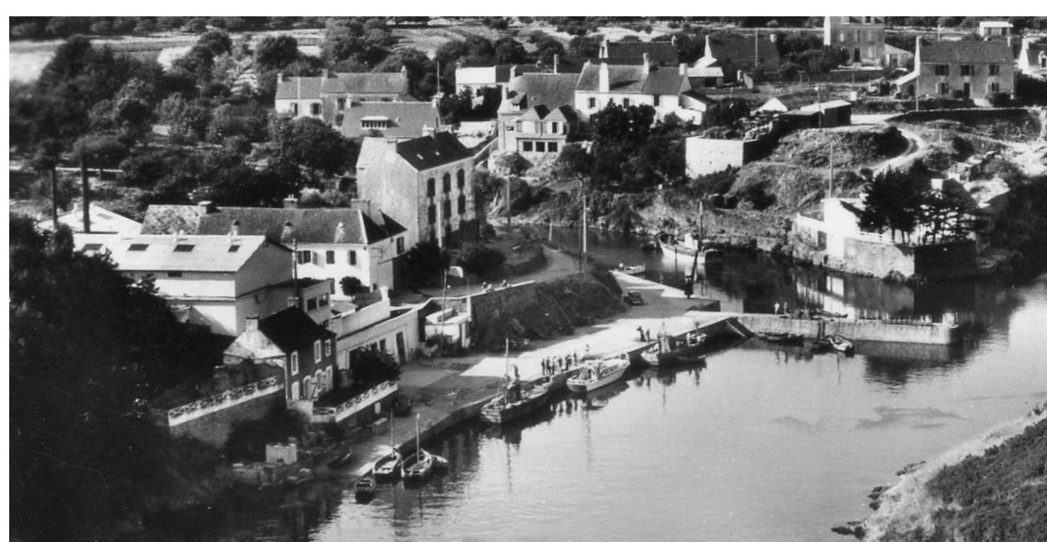
Vue d'ensemble après la construction du quai vers 1950. Nous voyons la passerelle de l'usine qui prolongeait la voie passant devant le Ti Bras
