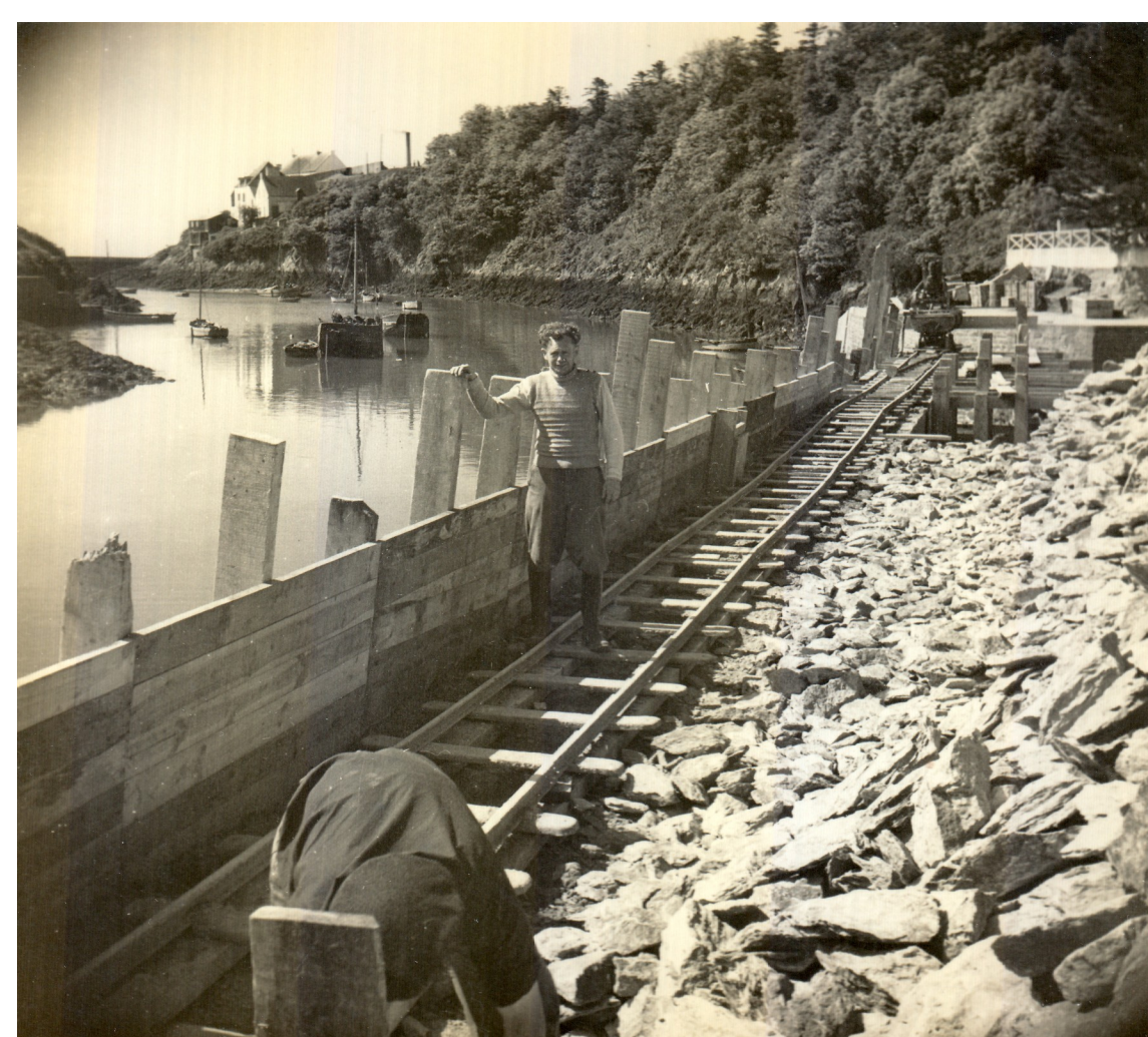
Mr Keroulin, ouvrier sur le quai en construction
