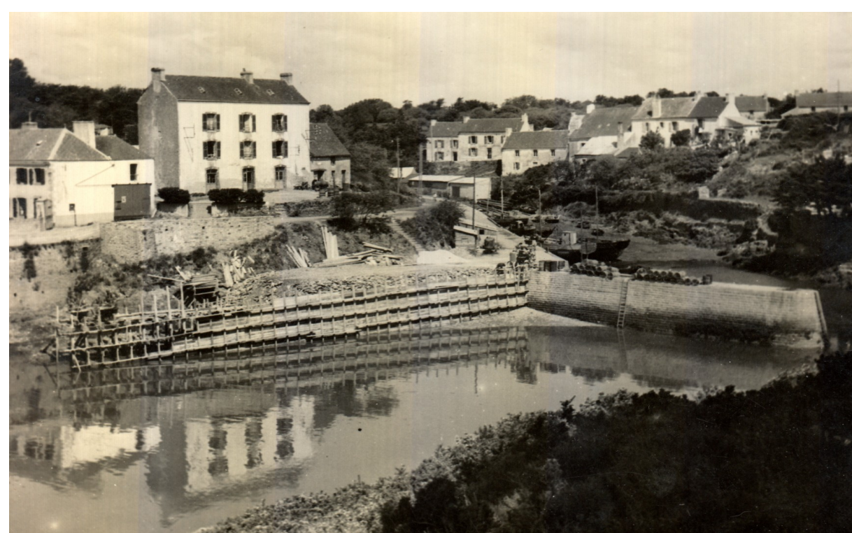
Construction du quai joignant le quai Chancerelle au môle de Porz Bagou (1949)
