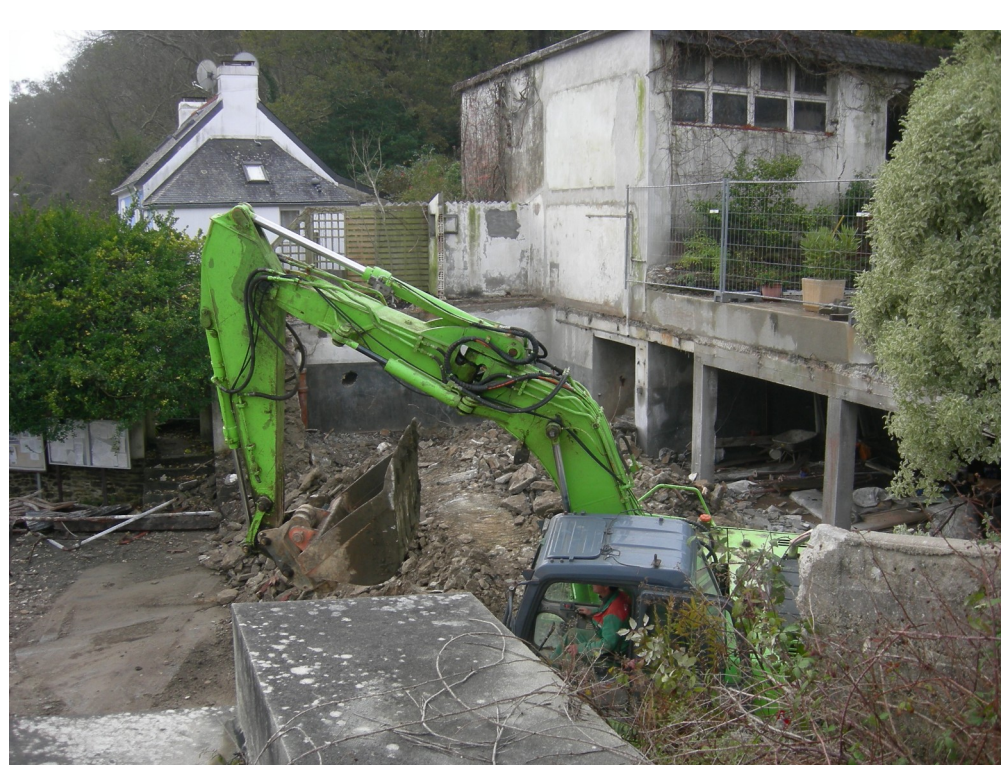
Démolition de la passerelle
