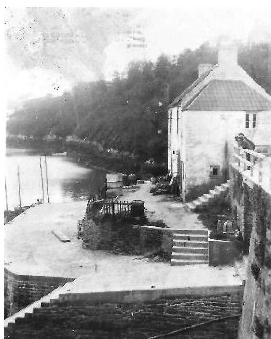
Détails du quai Chancerelle
