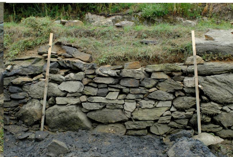
Au cordeau on aligne et on remplit bien derrière , des m3 de pierres
